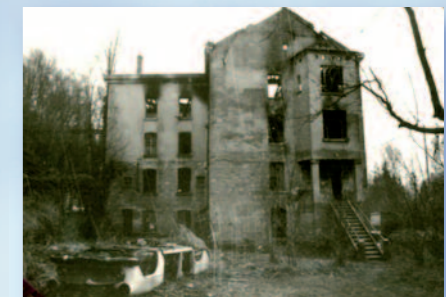
La façade postérieure du Moulin Rose après l'incendie (1971) - Archives municipales d'Osny, 301
