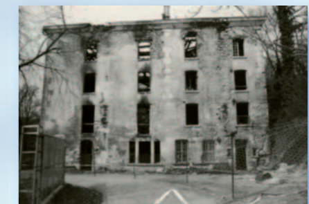
La façade principale du Moulin Rose après l'incendie (1971) - Archives municipales d'Osny, 301
